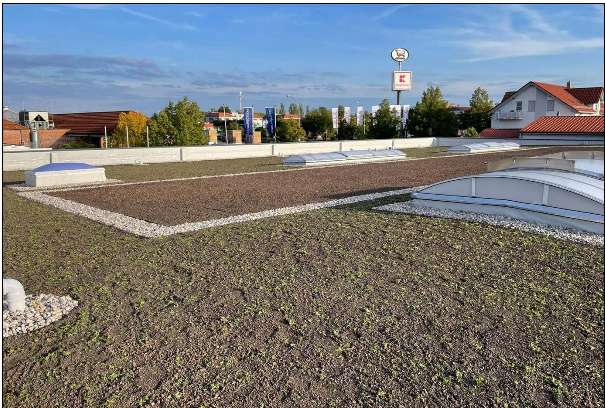
Abb. 4: Anlage einer extensiven Dachbegrünung auf dem Dach des ehemaligen Möbelhauses (Stand: 23.09.2022, Blickrichtung Südost)
