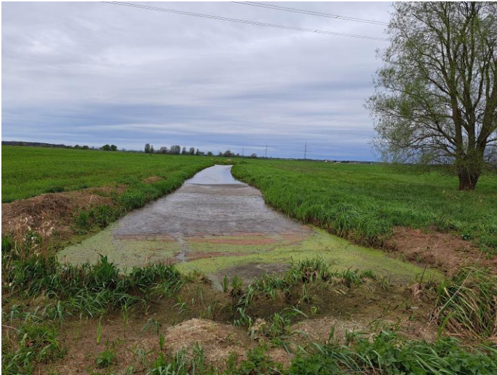
Foto 10: Breiter Grabenverlauf innerhalb des Plangebietes
