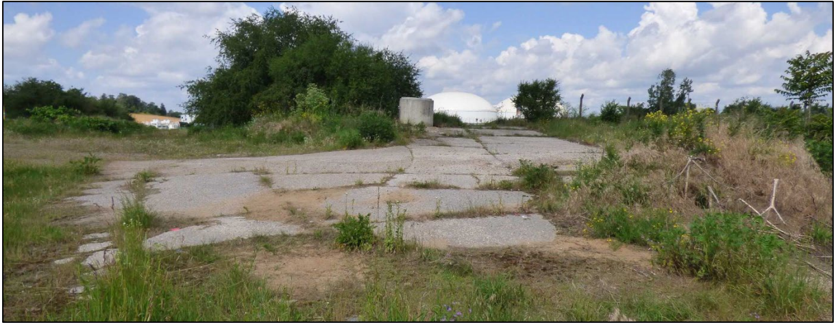
Abb. 9 Weg zur Rampe im östlichen Plangebiet
