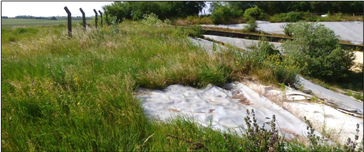
Abb. 12 Ruderalflur an Dammkronen östlich Güllelagune
