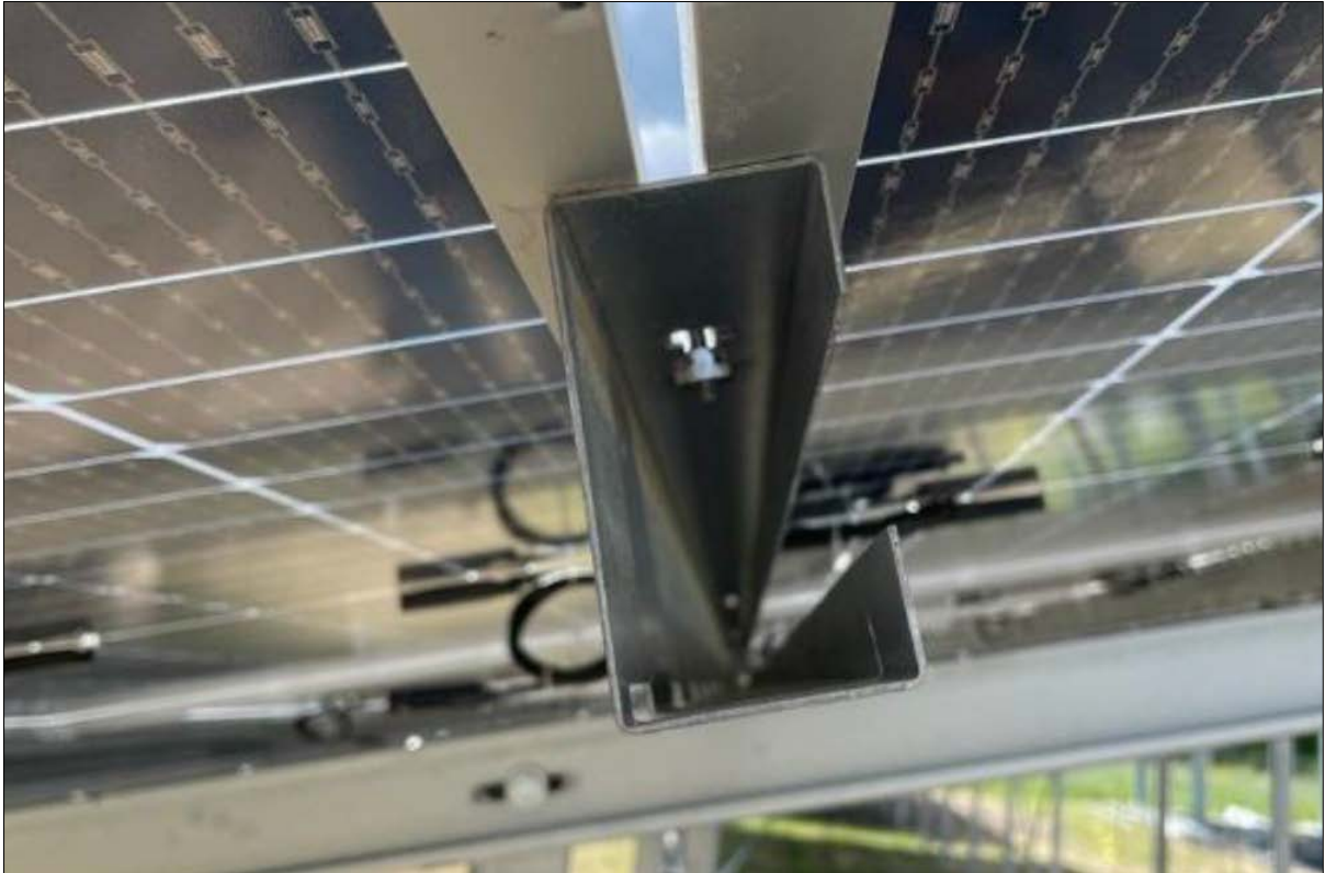
Abb. 6 Regenwasserverteilsystem
