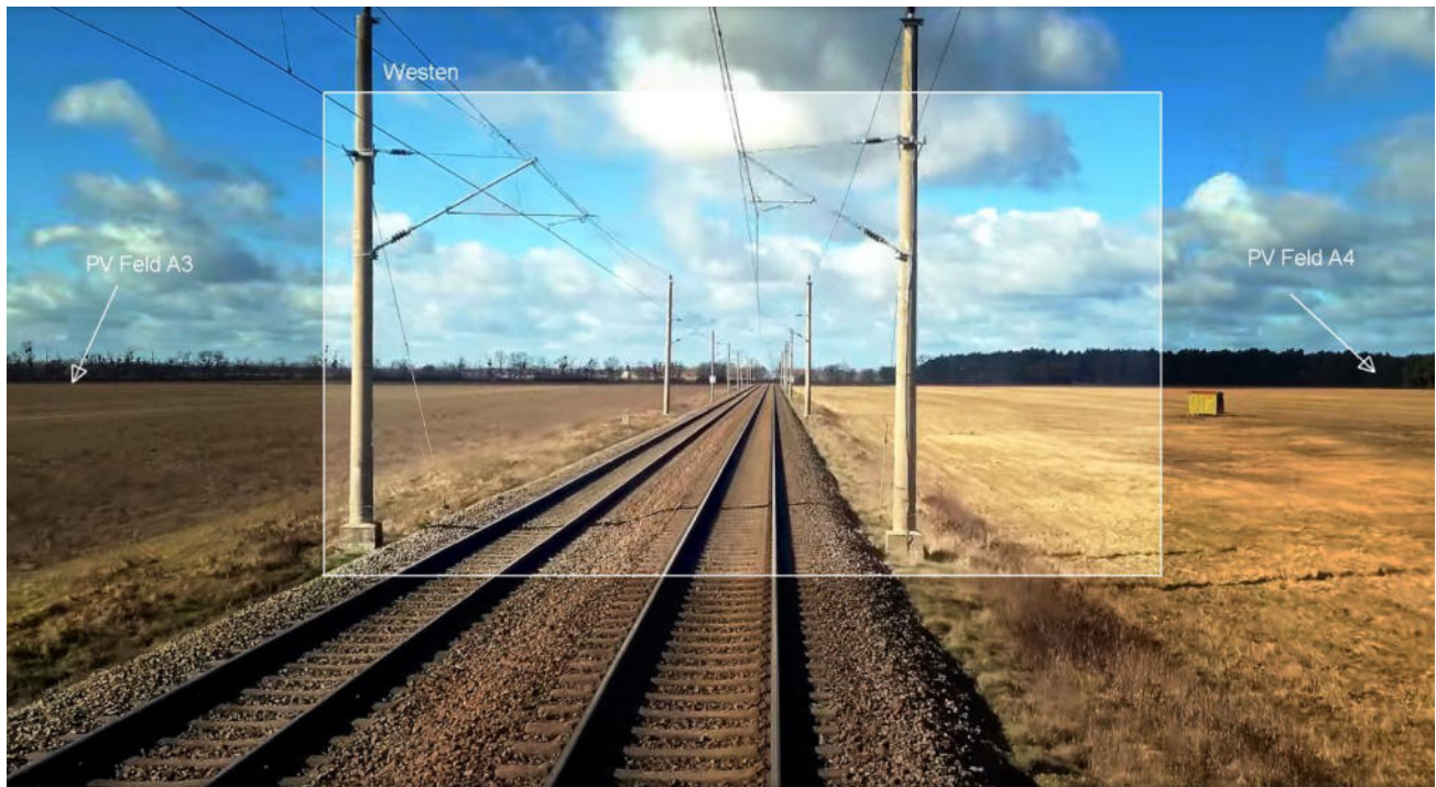
Bild 4.5.2: Foto am Messpunkt P5, Fahrt Richtung Westen (Quelle Youtube Video aQC3-e2fBUw , Minute 31:52)
