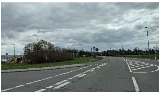
Geh- und Radweg Panitzscher Straße
