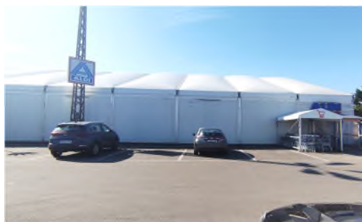
Provisorische Aldi-Filiale. Eingang und Außenseite
