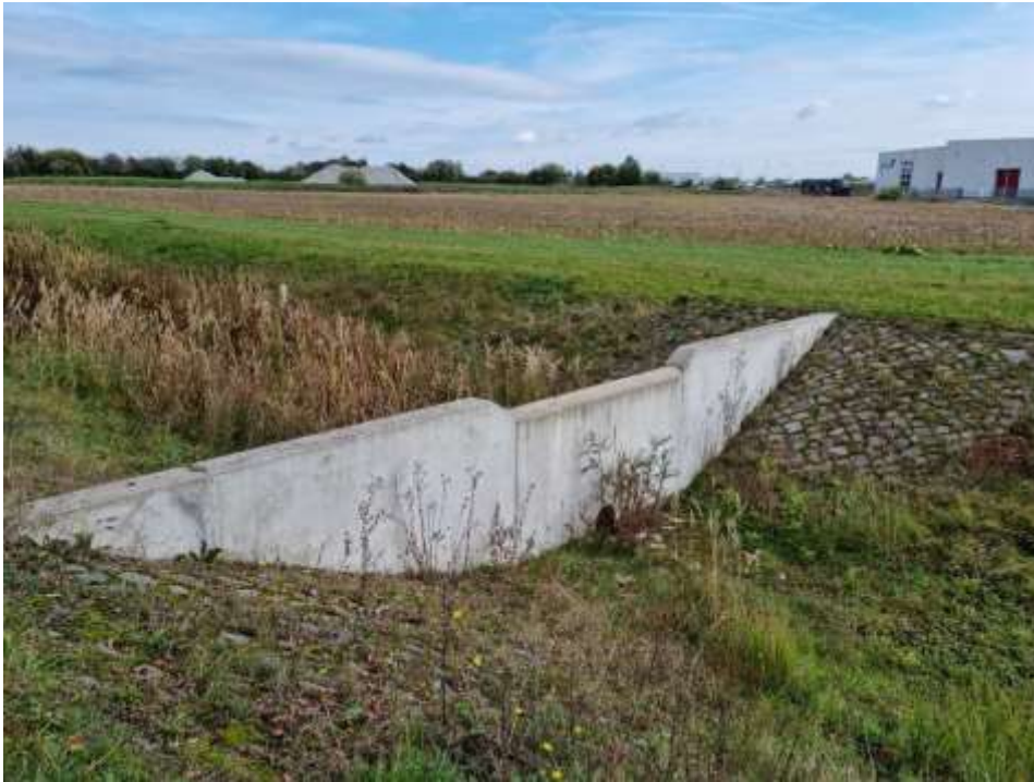
Abbildung 2 Vorhandene Betonschwellen im Graben (Stand: Oktober 2021)
