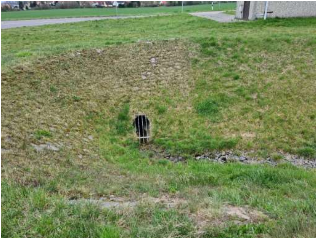
Abbildung 3 Vorhandener Auslauf DN600 Beton Vergittert, soll durch Auslauf DN300 ersetzt werden (Stand: April 2022)
