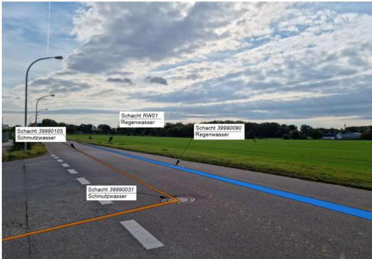
Abbildung 4 Schächte im Kreuzungsbereich "An der Hufe"/"An der Laakenwiese"
