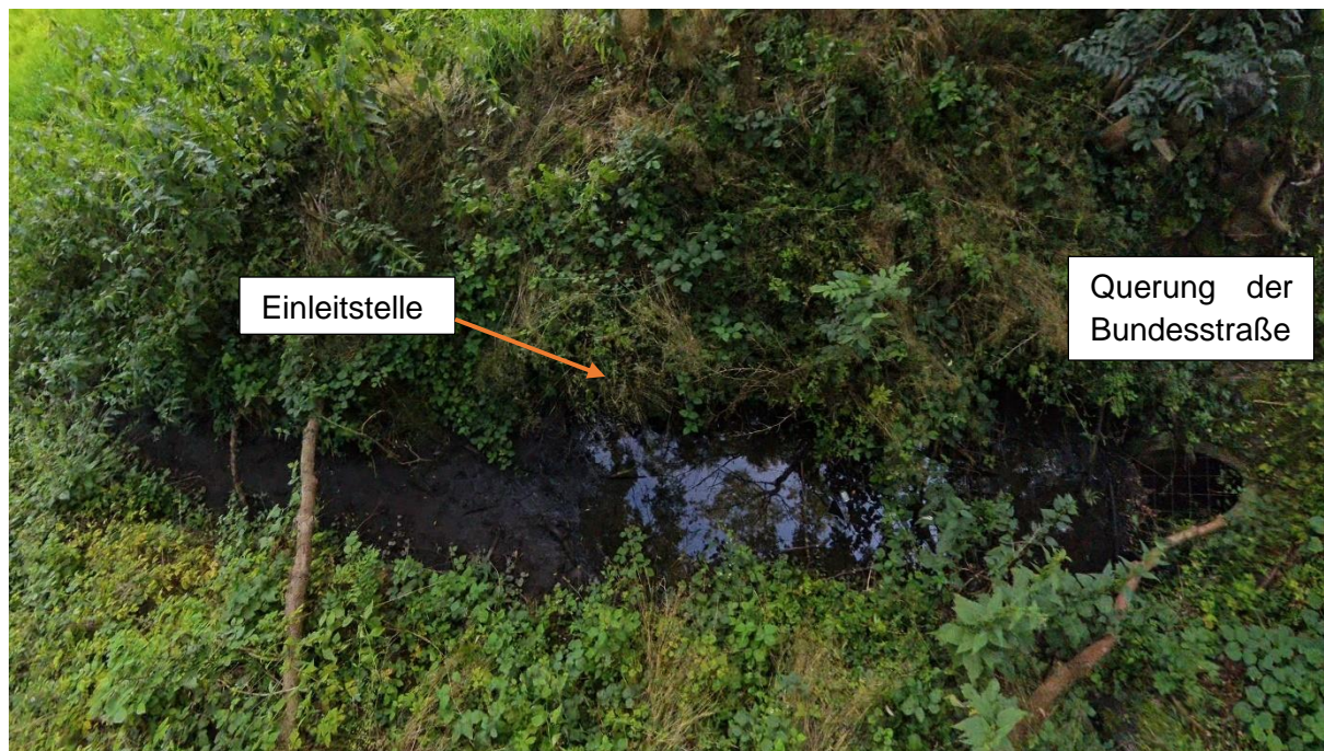
Abbildung 5: Einleitstelle und Querung der Bundesstraße 87
