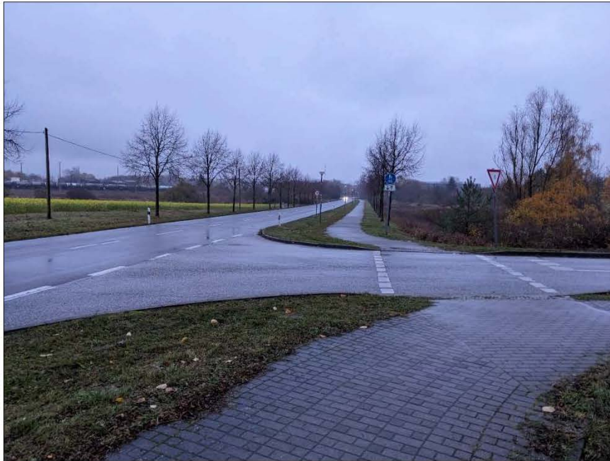
Abb. 5: Querungsstelle über die Joachimsthaler Straße
