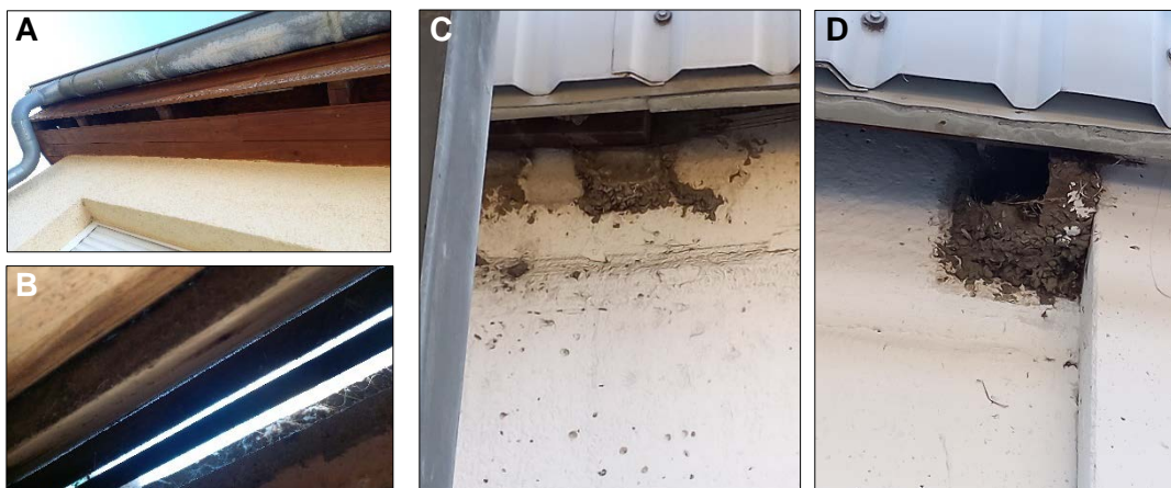
Abb. 16 Nester am Gebäude 2, A: Attika am Gastronomischen Gebäude ohne Nistmaterial, B: Nistverdacht Hausrotschwanz, C-D: Mehlschwalbennester an der Kaufhalle Kaufland
