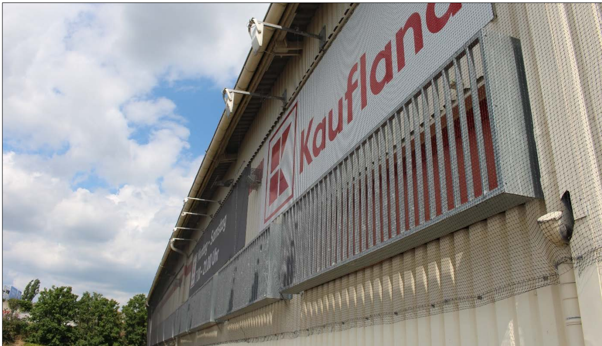
Abb. 15 Südseite Kaufland mit Schutznetz
