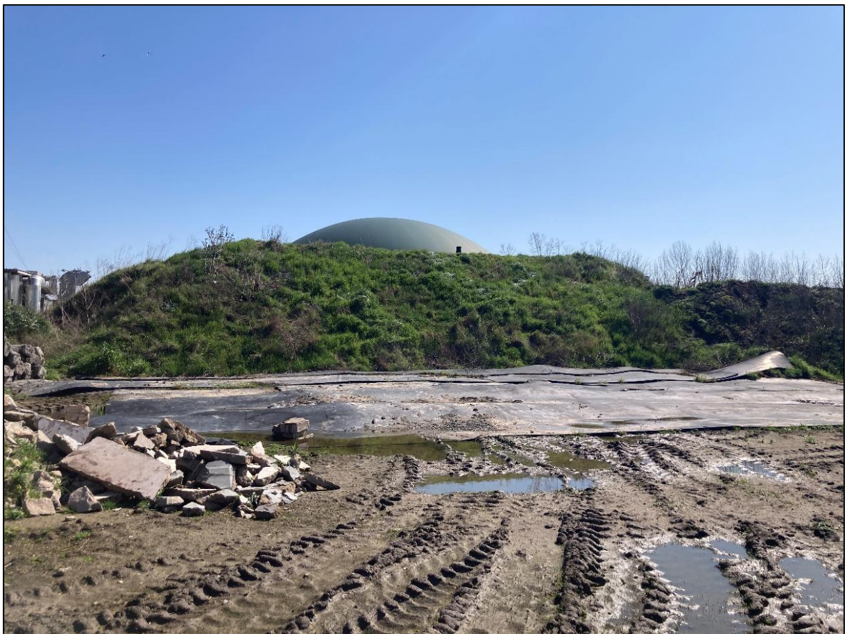
Abb. 10 Umwallung bestehende BGA und Schuttablagerungen
