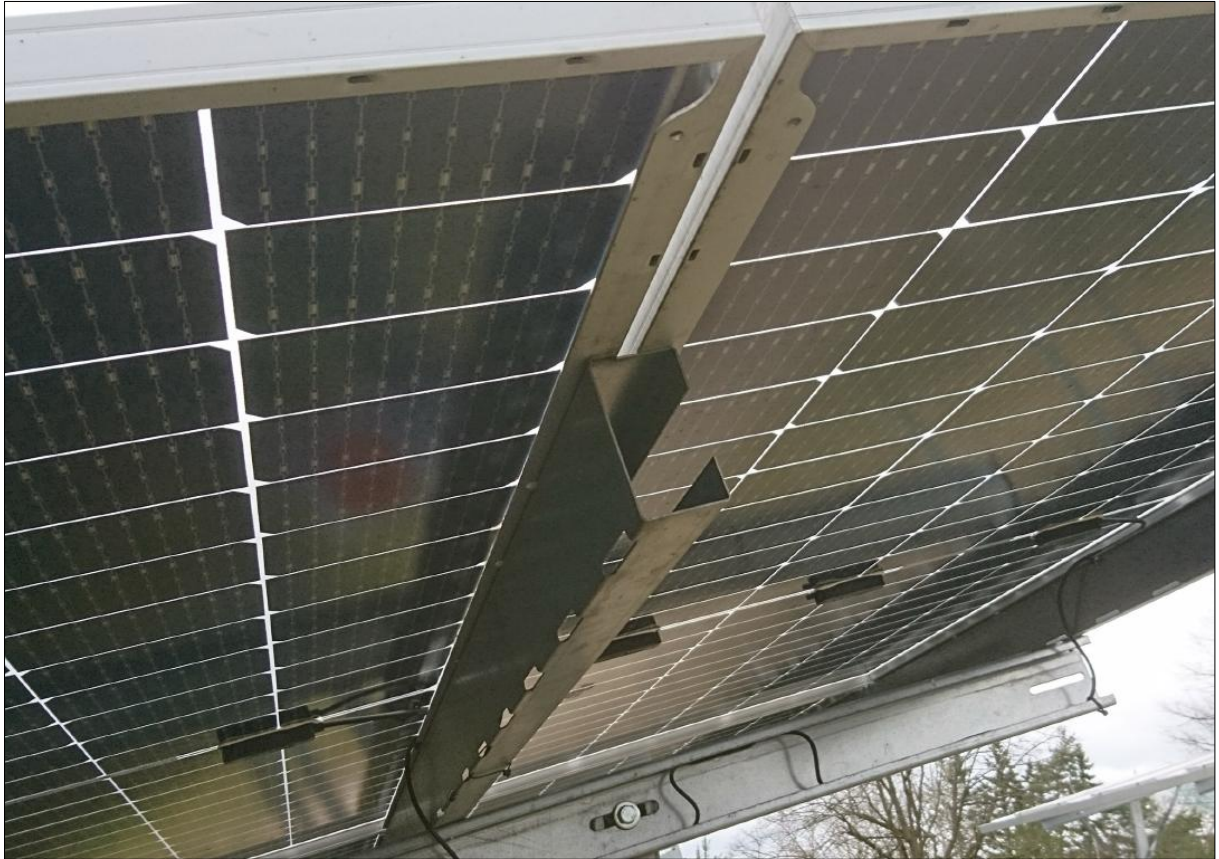
Abb. 6: Regenwasserverteilungssystem (SUNfarming 2024)
