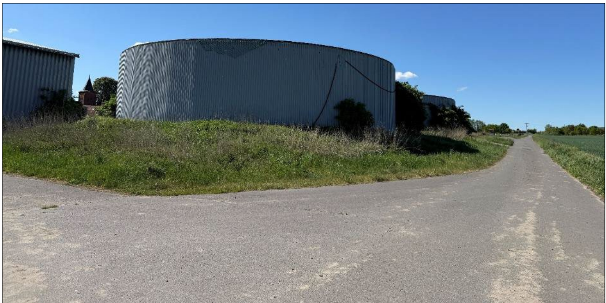
Abb. 8 Teil der stillgelegten Biogasanlage
