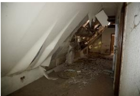
Bild 12: Dachboden Richtung Osten
