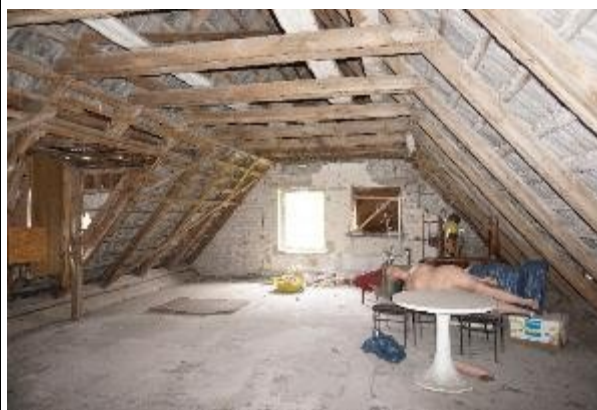
Bild 11: Dachboden Richtung Westen
