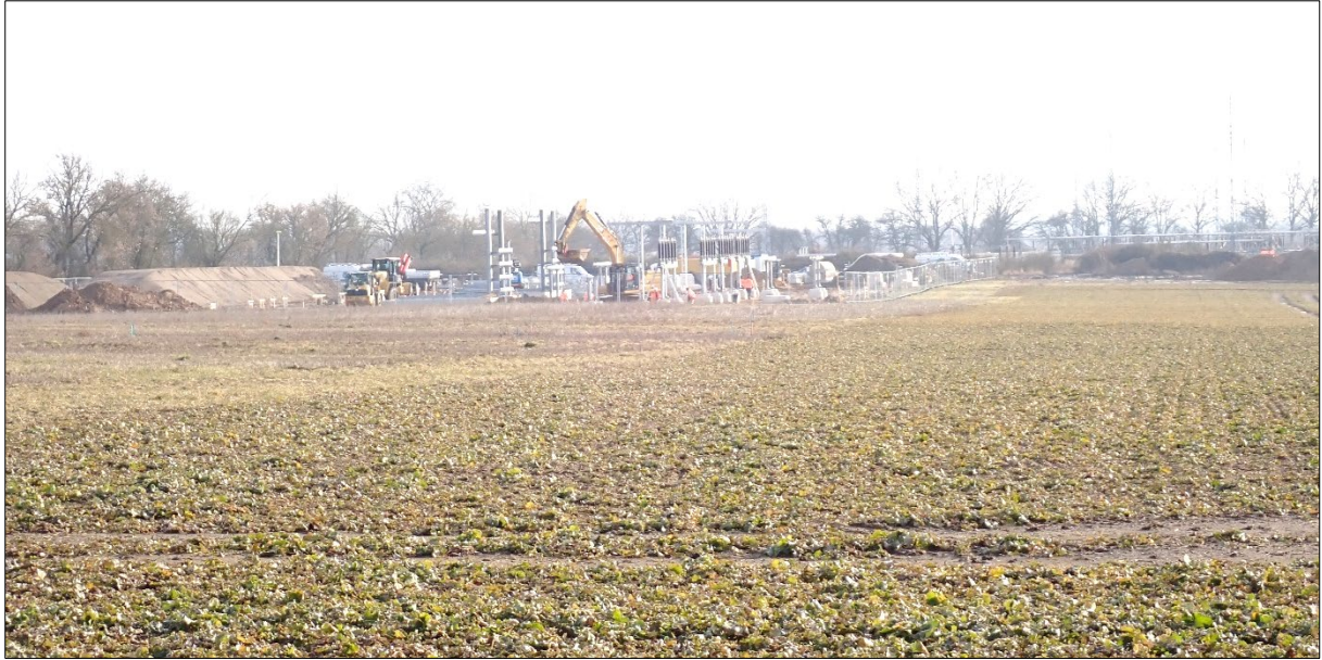
Abb. 8 Blick im Norden des Plangebiets Richtung Osten (auf Baustelle der E.DIS Netz GmbH und Umspannwerk Heinersdorf, dahinterliegende Baumreihe Richtung Tempelberg, BÜRO KNOBLICH GMBH 02/2026)
