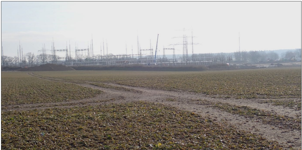
Abb. 9 Blick vom Plangebiet Richtung Osten, Umspannwerk Heinersdorf (BÜRO KNOBLICH GMBH 02/2026)
