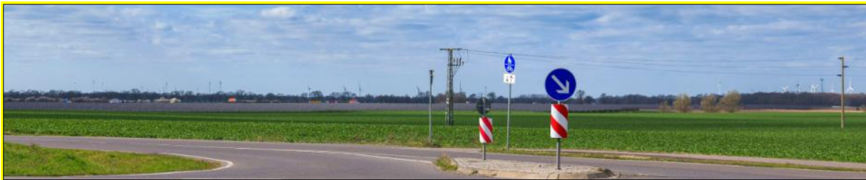
Abb. 16 Blick von der L16 mit Photovoltaikanlage (LANDVIS 2026)
