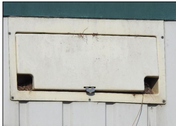
Abb. 22: Neststandort des Feldsperlings in den Nischen des Containers (14.04.2025)
