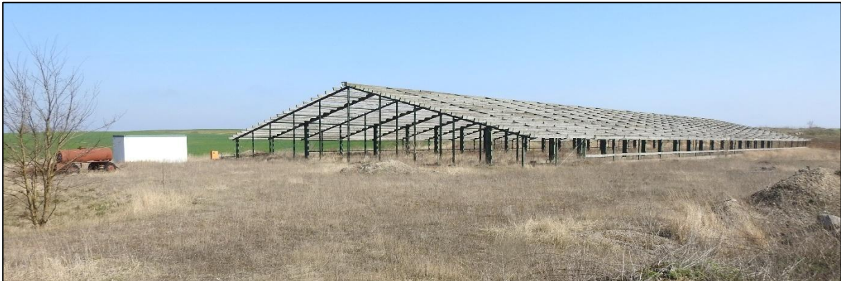
Abb. 20: Rohbau der geplanten Stallanlage im westlichen Bereich von TF4 (28.03.2025)
