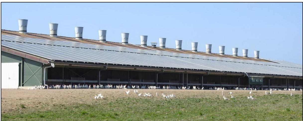
Abb. 4: Blick auf die Legehennen-Stallanlage in TF2 mit Brutrevieren von Rauchschwalbe, Bachstelze und Haussperling (14.04.2025)
