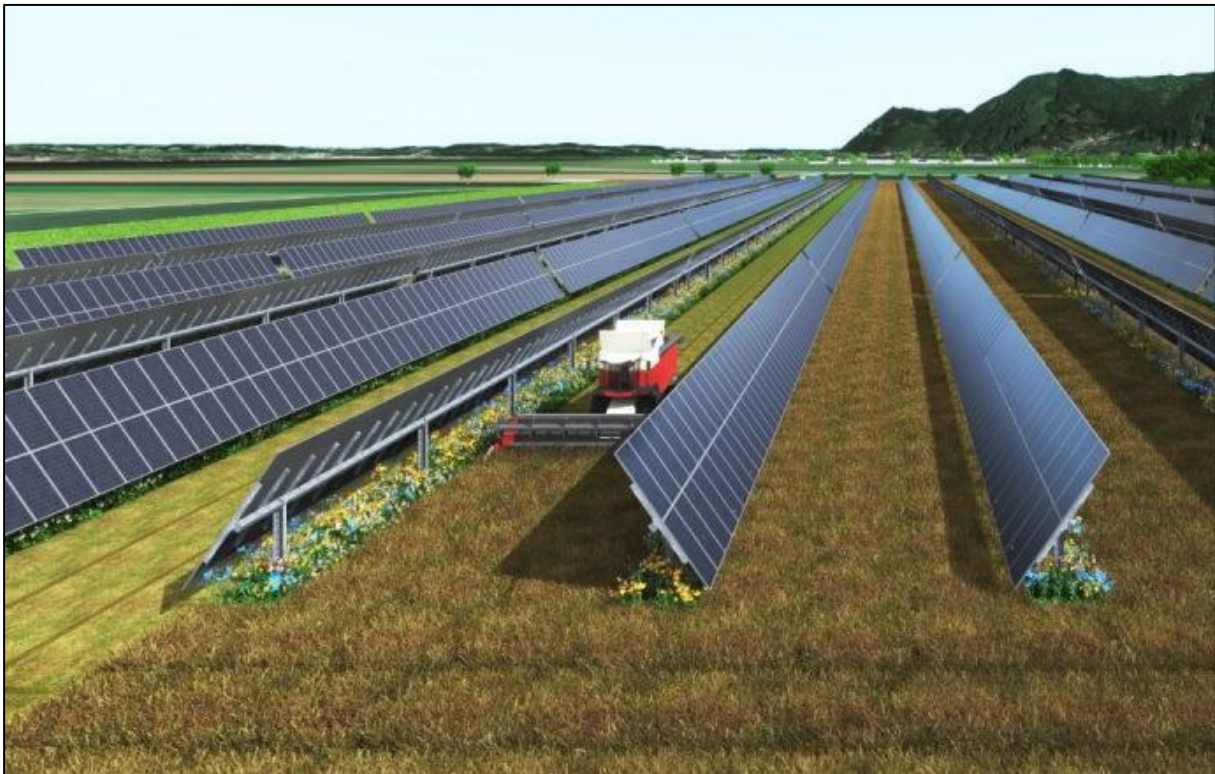
Abb. 4: Beispiel für den Agri-PV-Landwirtschaftsmodus mit Tracker-Modulen. Quelle: https://www.energiepark.at/agri-pv-sonnenfeld-bruck-leitha/
