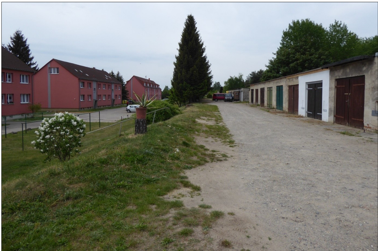
Abb. 11: Blickrichtung Westen, mit Garagenhof rechts und Grünfläche am Hang links (BÜRO KNOBLICH, 05/2022)
