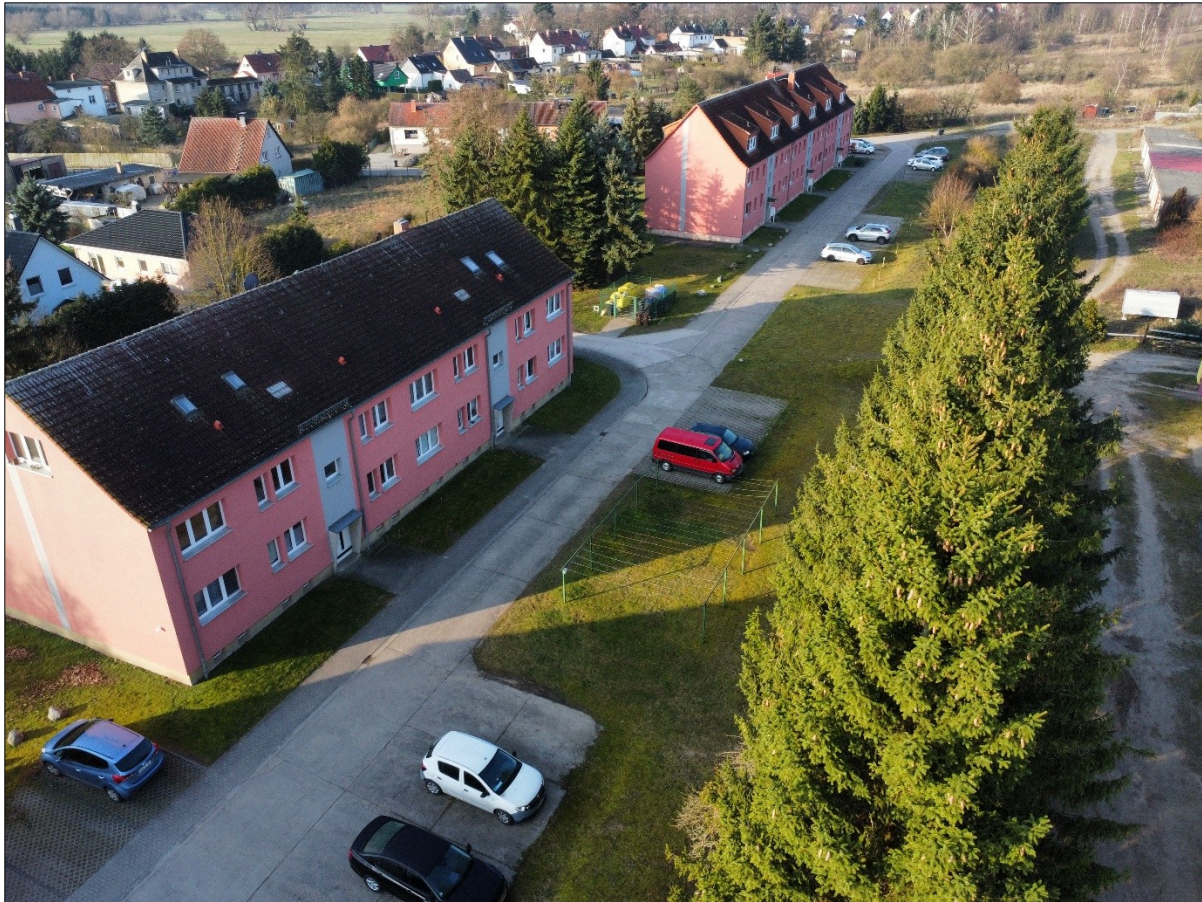
Abb. 3: Südliches Plangebiet mit Bestandsbebauung und Parkplätzen (BÜRO KNOBLICH 2024)
