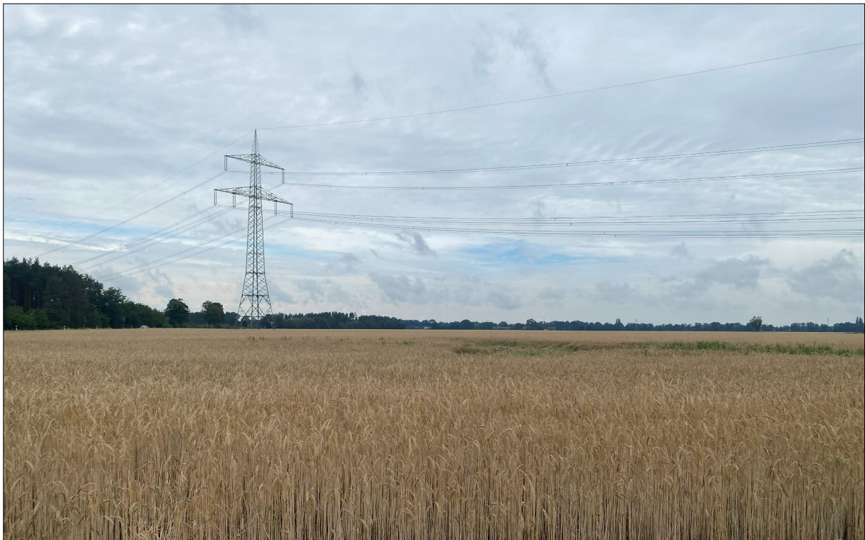
Abb. 11 im Süden des Plangebiets befindliche 380-kV-Leitung
