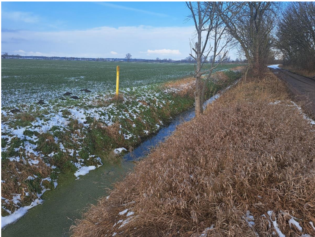
Grabenbereich entlang von Feldweg
